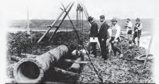
配水管布設風景（小名浜町上水道創設当時）
