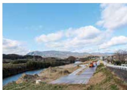
夏井川の掘削工事の状況 (令和2年12月)
