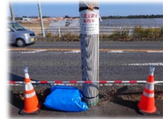
■AIカメラ設置状況
