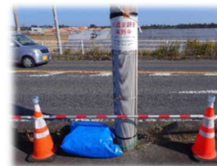
■AIカメラ設置状況
