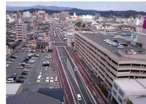
▼（都）新川町谷川瀬線 H27全線供用
