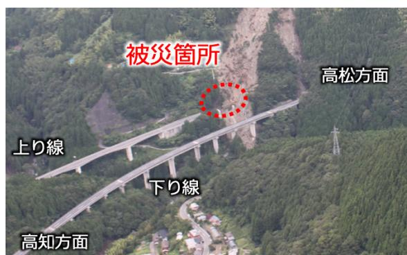
上下線の被災を免れた高速道路の分離構造
