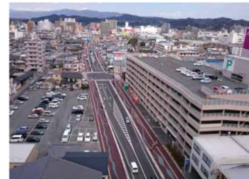
▼（都）新川町谷川瀬線 H27全線供用
