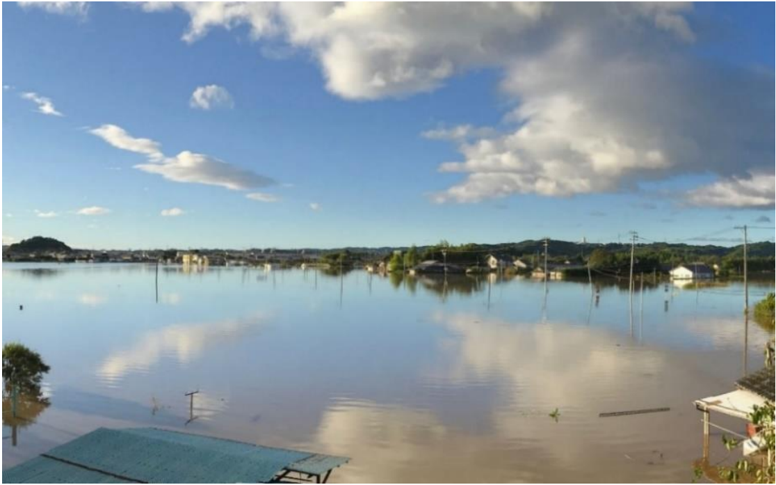
夏井川の氾濫による浸水被害（平窪地区）
