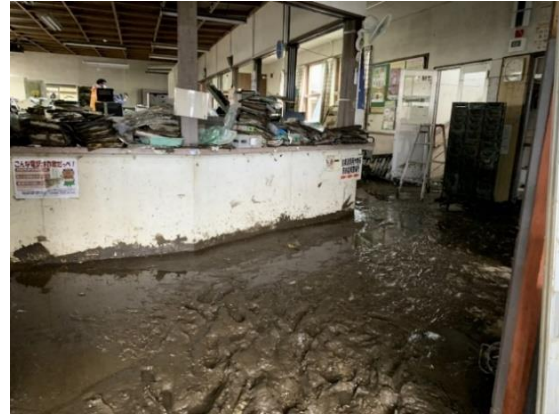
被災した小川支所（小川地区）
