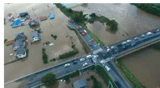
浸水した平幕ノ内・平鯨岡地区と混雑する平橋
