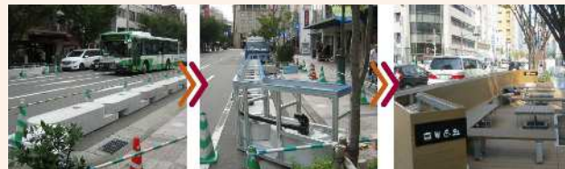
写真. (例)自在R連続基礎を活用したパークレットの設置
