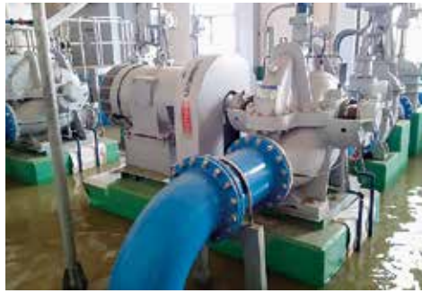
水が引いてきたポンプ室（平浄水場）
