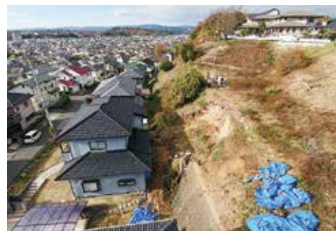
泉ヶ丘二丁目地区がけ崩れ状況
