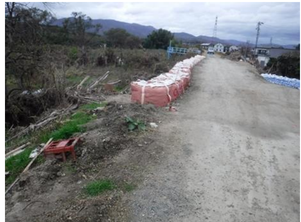
【令和元年10月 台風第19号による堤防決壊・仮復旧状況】（二級河川夏井川 平下平窪地区）
