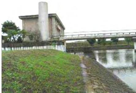
排水機場の法面での生育状況
