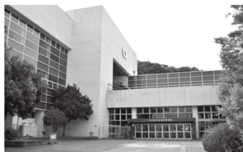
改修が行われている総合体育館
