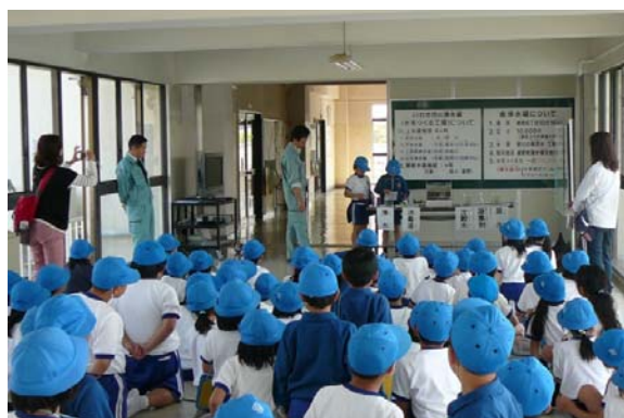
小学校の浄水場見学の様子
