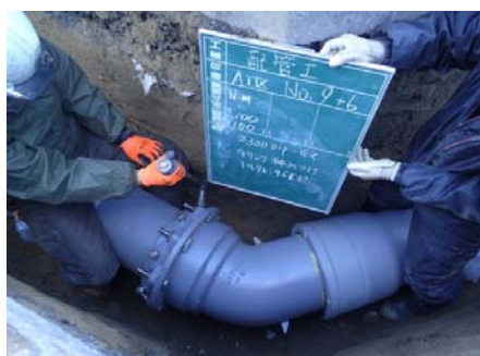
耐震管布設の様子
