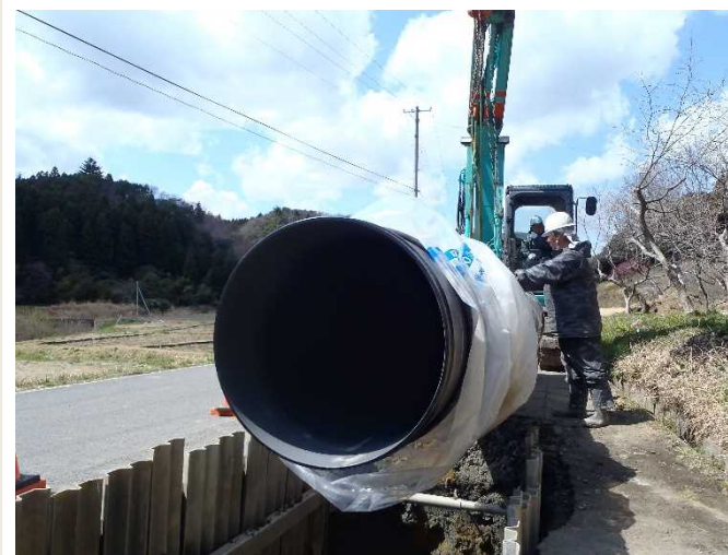
写真 φ800布設状況
