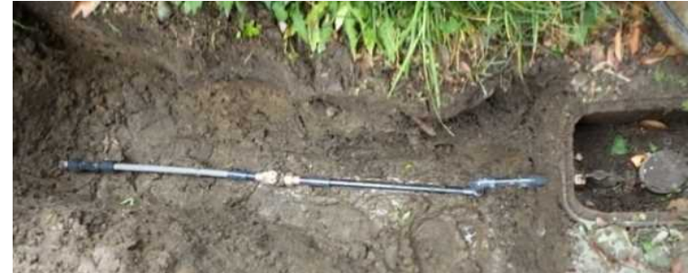
図 鉛製給水管の布設替えの状況 左：施工前（鉛製管） 右：施工後（ビニル管）
