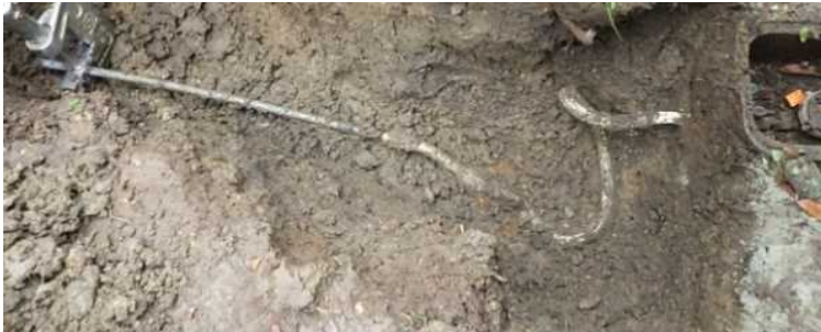
図 鉛製給水管の布設替えの状況 左：施工前（鉛製管） 右：施工後（ビニル管）
