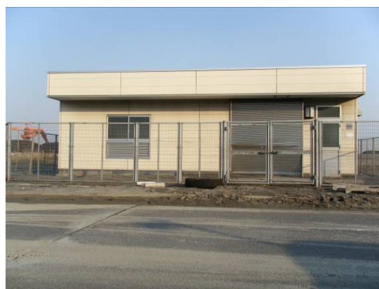
分岐施設（電源設備）
