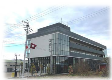
市地域防災交流センター久之浜・大久ふれあい館 （津波避難ビル）
