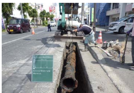
老朽管更新の様子
