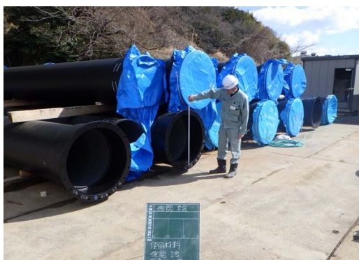
基幹浄水場連絡管整備事業の様子① (φ800mm耐震管の材料確認)
