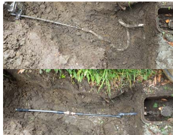
鉛製給水管の布設替えの状況
