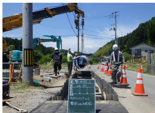
基幹浄水場連絡管整備事業の様子② (φ800mm耐震管の布設)
