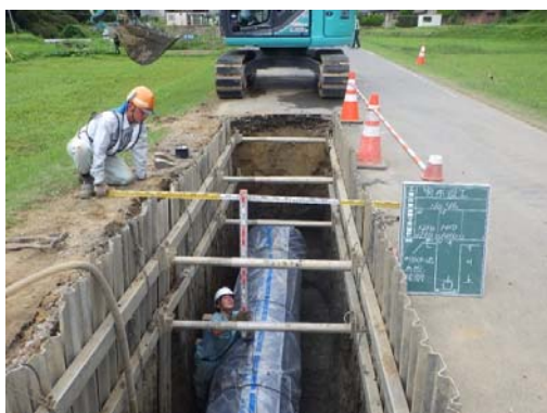
基幹浄水場連絡管整備事業の様子③ (φ800mm耐震管の布設)
