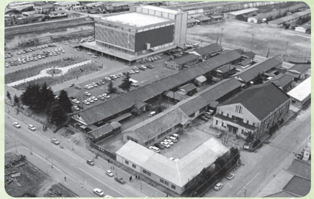
市平市民会館、市役所仮庁舎（旧県立平商業高校）
