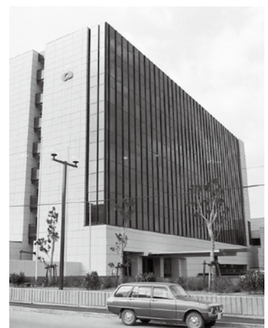
▶市役所本庁舎が完成
