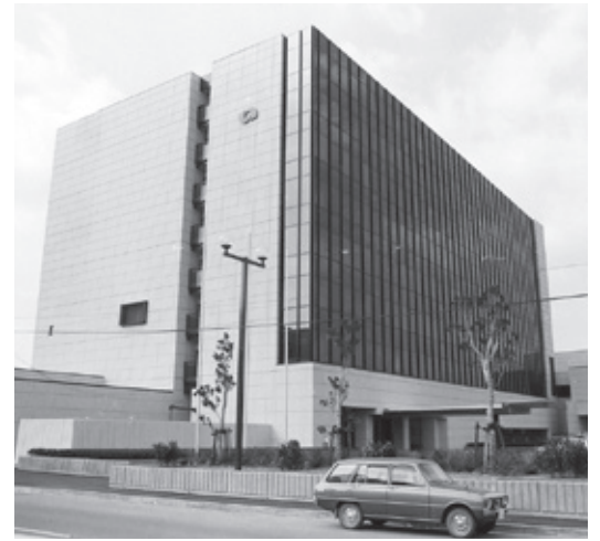
市役所本庁舎が完成
