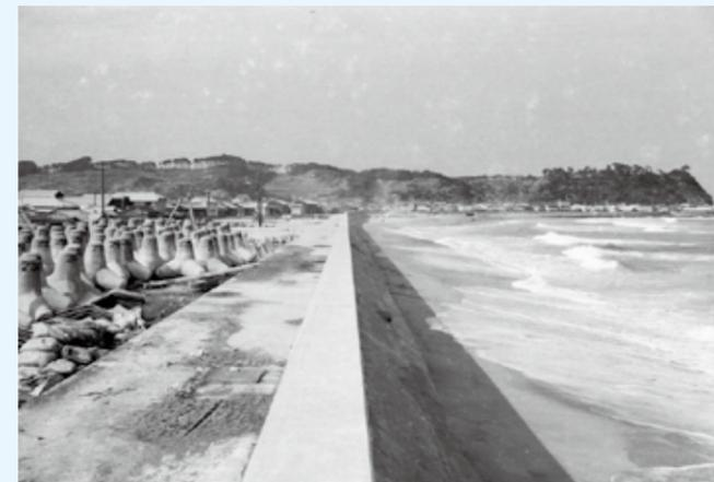
四倉海岸の防潮堤復旧工事 (左に見える波消しブロックが補強のため海側に投入された) [昭和40 (1965) 年ごろ、小泉屋文庫提供]
