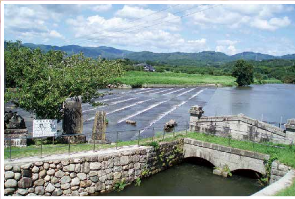
磐城小川江筋取水堰（斜め堰） 江戸時代に建造された国内でも数少ない斜め堰の1つです。
