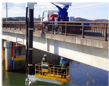
▲ 橋梁点検車点検（橋梁）
