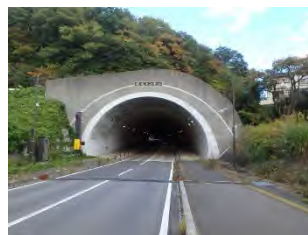
湯本トンネル（上荒川・台山線）
