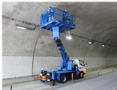
▲ 高所作業車点検（トンネル）
