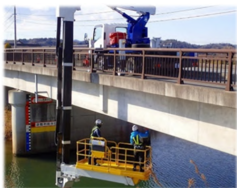
▲ 橋梁点検車点検（橋梁）
