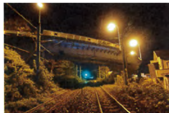
関田跨線橋（窪田・関田線）
