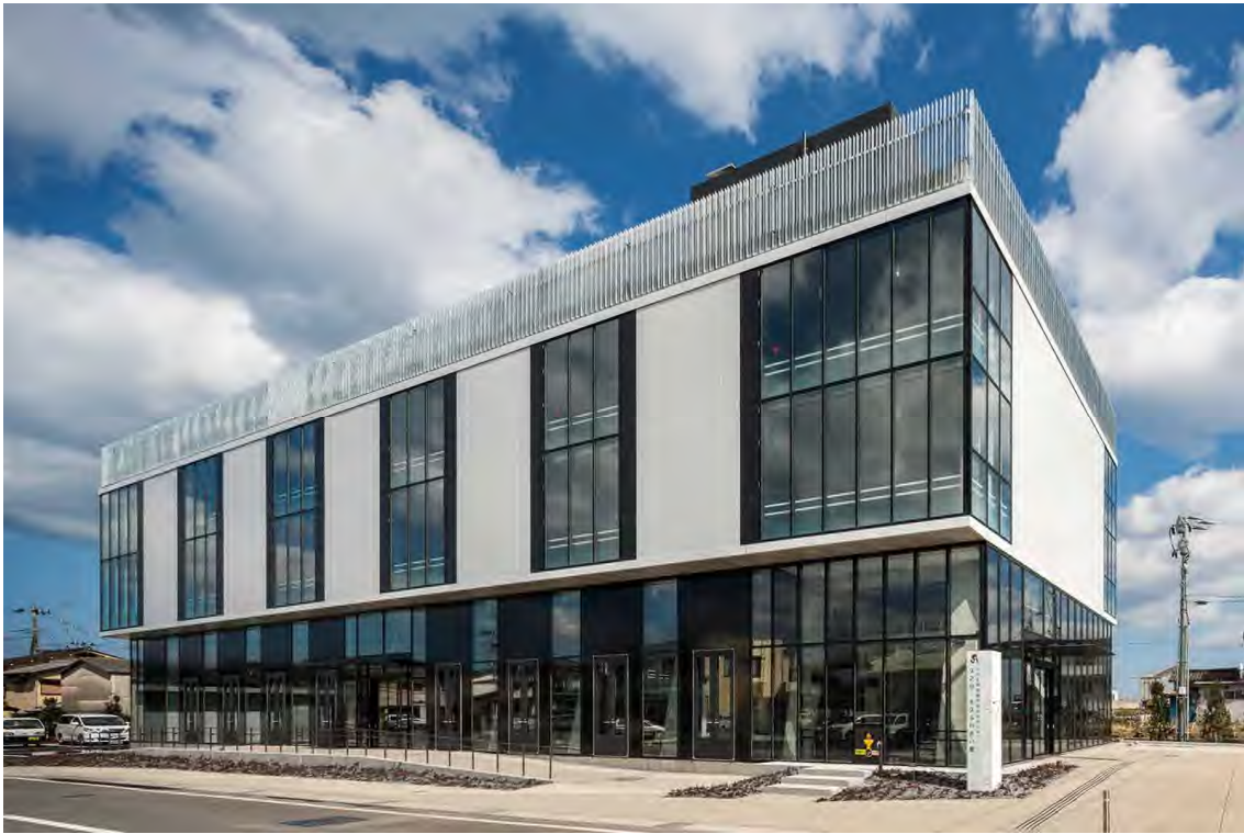
参考・久之浜地区防災拠点施設（津波避難ビル）竣工写真
