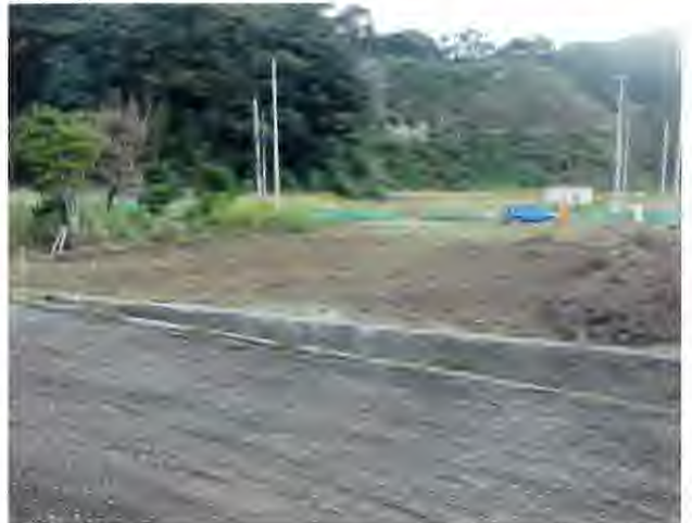
現場撤収 事務所撤去後状況
