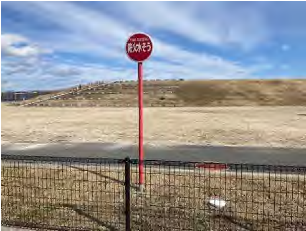
耐震性貯水槽（薄磯①）
