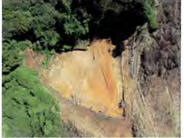
図面の作成、写真撮影 薄磯大平遺跡全景
