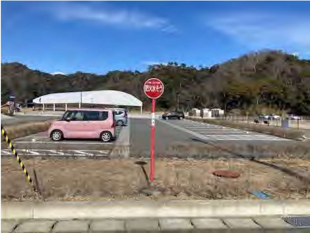
防火水槽耐震性貯水槽（豊間①）
