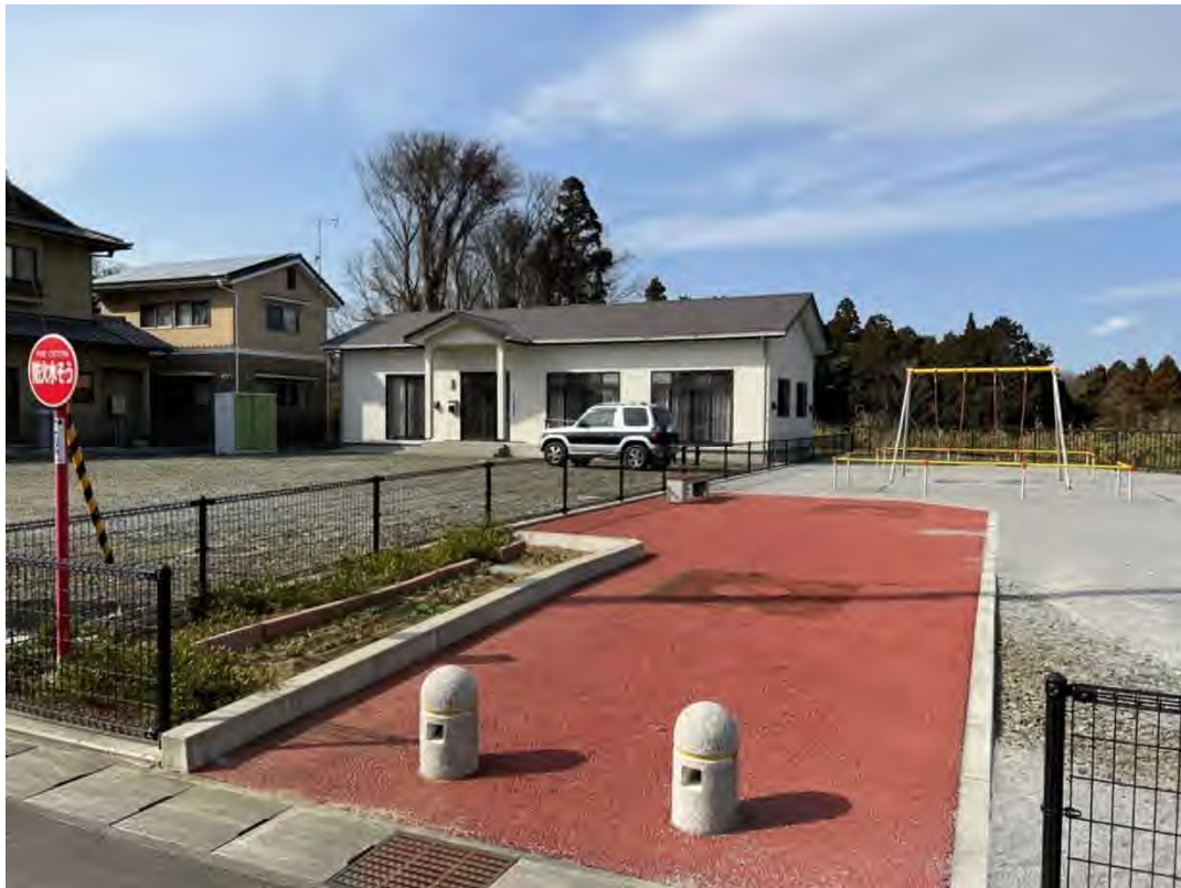
耐震性貯水槽（岩間②）
