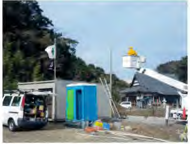
発掘調査前段階作業 仮設電気工事
