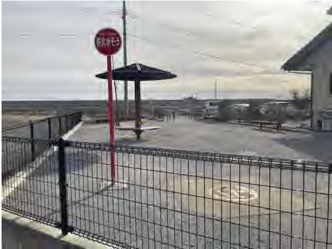
耐震性貯水槽（小浜②）
