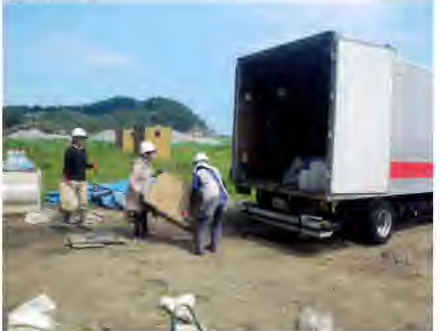
現場撤収 機材搬出
