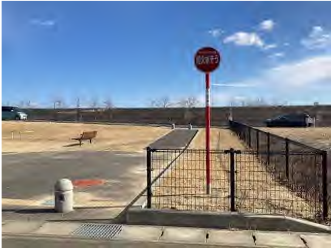
防火水槽耐震性貯水槽（豊間③）
