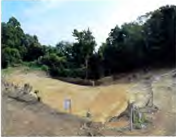
遺構掘削作業 遺物包含層 1 完掘状況
