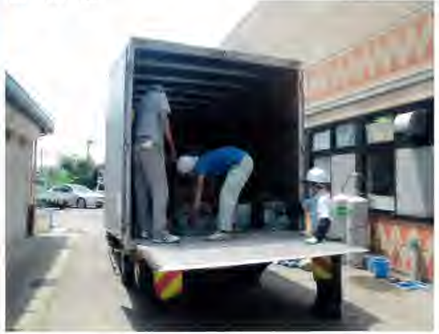
事務所設置、器材搬入 器材搬入作業
