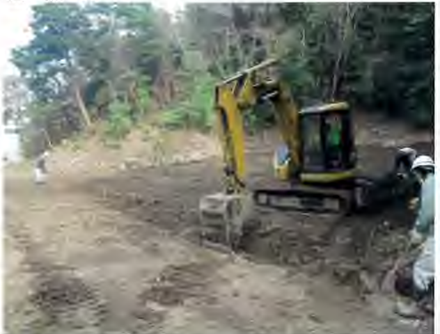
埋め戻し 埋め戻し・整地作業
