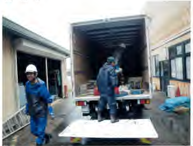
事務所設置、器材搬入 器材搬入作業
