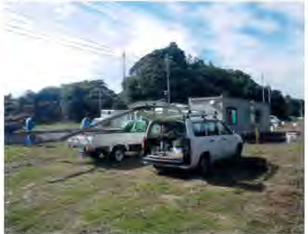
発掘調査前段階作業 仮設電気工事
