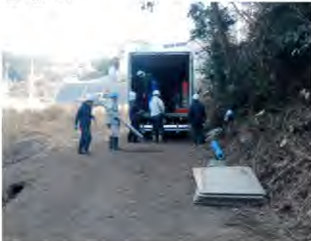
現場撤収 器材撤収
