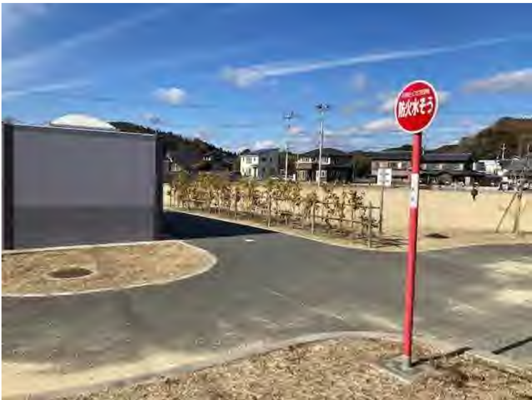
防火水槽耐震性貯水槽（豊間②）
