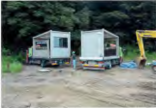
事務所設置、機材搬入 仮設事務所等設置作業
