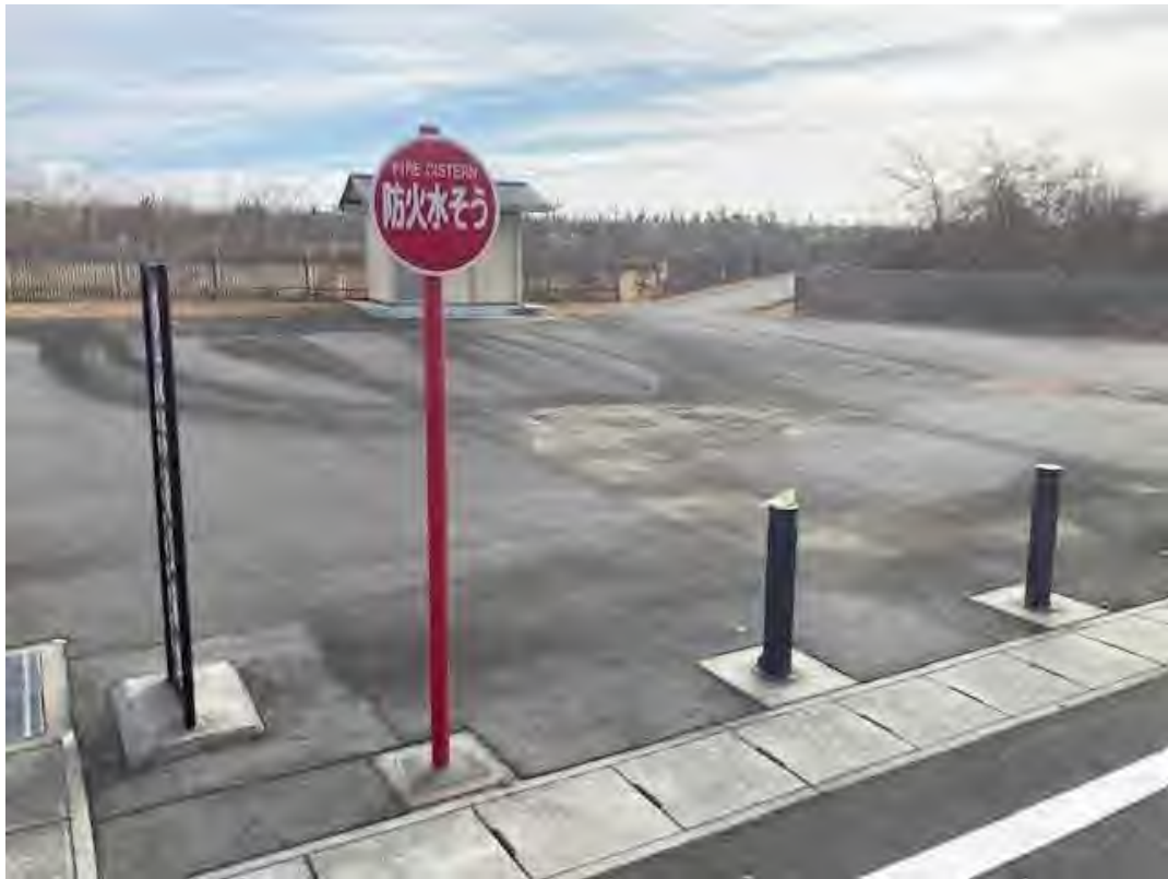
耐震性貯水槽（久ノ浜④）
