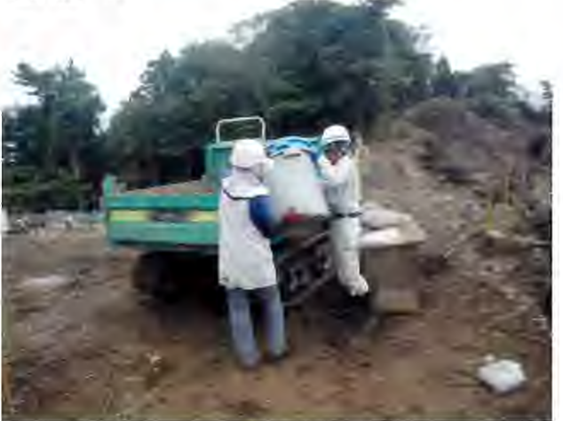
現場撤収 現場機材撤収
