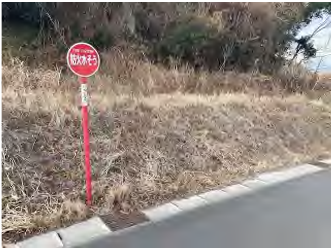
耐震性貯水槽（小浜①）
