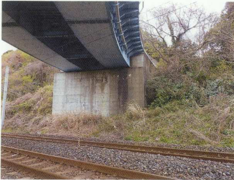
大津港・勿来間関田こ 線橋耐震補強工事
