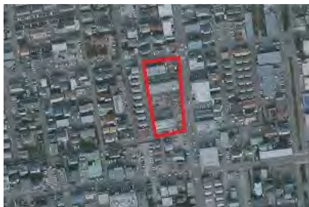
着工前 (既存の市教職員住宅を解体後着工)
