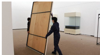
パネルを骨組みにはめ、固定する
