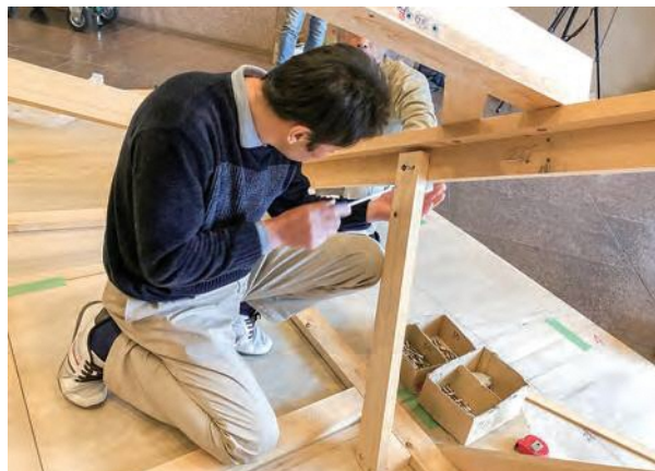
12 2階床梁を斜めに支える「頬杖」
