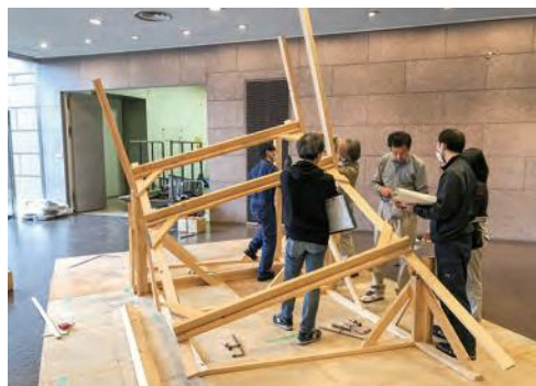
13 2階部分の柱を立てていく
