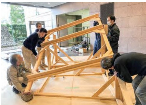
11 2階部分の床梁を載せる
