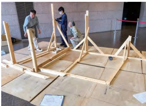
10 1階部分の柱を立てていく
