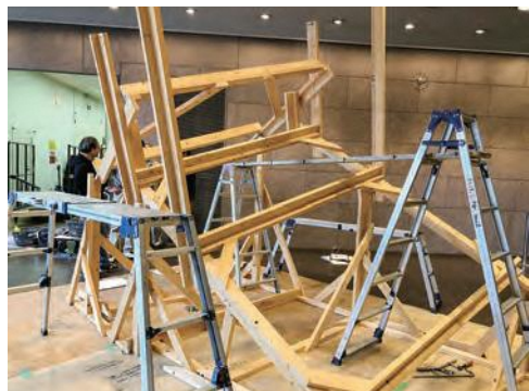
14 2階部分を組み上げていく…完成間近!
