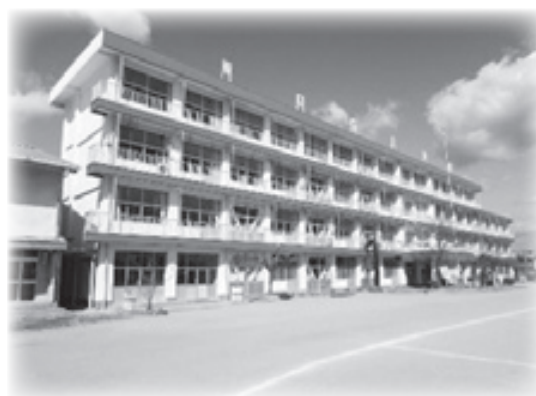
外壁等改修工事後の校舎
