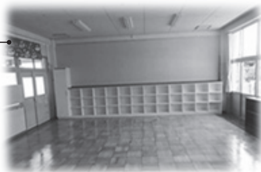
平第二小学校普通教室内部改修工事 (平成 30 年度実施)
