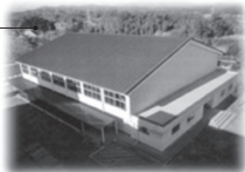
泉小学校屋内運動場屋根塗装工事 （平成29年度実施）
