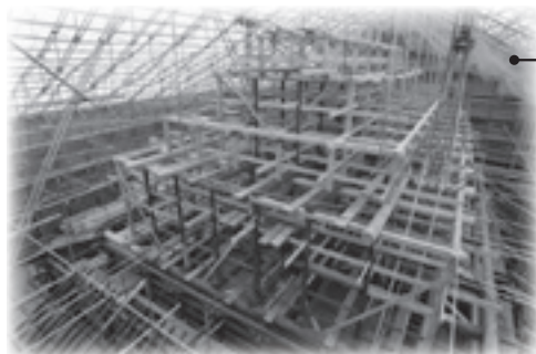
専称寺本堂保存修理の様子
