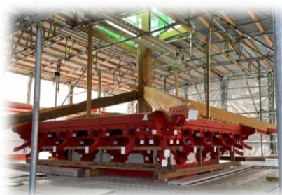
高蔵寺三重塔修復事業の様子
