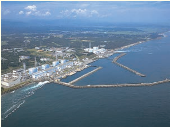
写真2-59 完成後の福島第一原子力発電所 〔東京電力(株)提供〕
