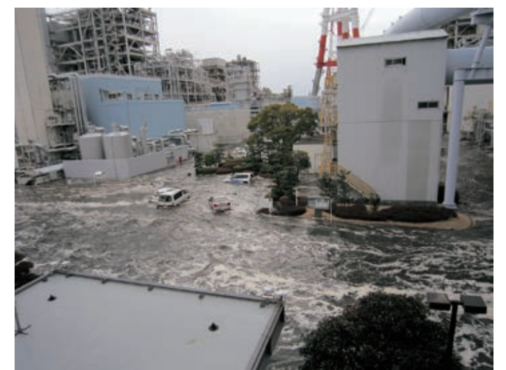
写真2-54 常磐共同火力（株）勿来発電所内に押し寄せる津波 〔3月11日 常磐共同火力（株）勿来発電所提供〕
