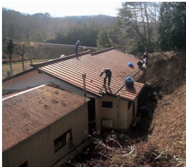
写真2-60 除染作業を実施（川前町） 〔12月14日 いわき市撮影〕
