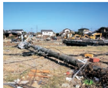
写真2-50 倒壊した電柱 〔4月5日 佐藤貴行氏提供〕
