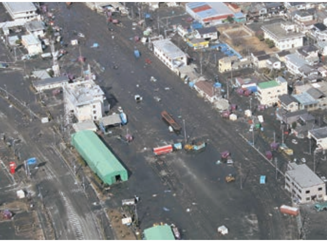
写真2-46 津波で線路上に散乱する、福島臨海鉄道の機関車やコンテナ 〔3月12日 福島県消防防災航空隊提供〕
