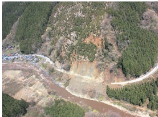
写真2-10 主要地方道いわき―石川線、田人町才鉢地内の崩落現場〔4月 陸上自衛隊第8普通科連隊提供〕
