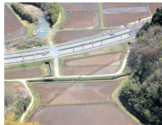
写真2-3 水田の地割れが見える常磐藤原町地内 道路は主要地方道いわき―石川線。簡易舗装した道路は色が変わっているのがわかる。 〔4月18日 福島県消防防災航空隊提供〕
