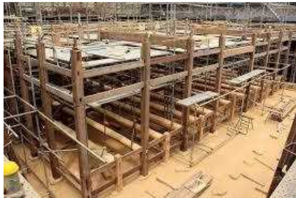
本堂修復工事状況
