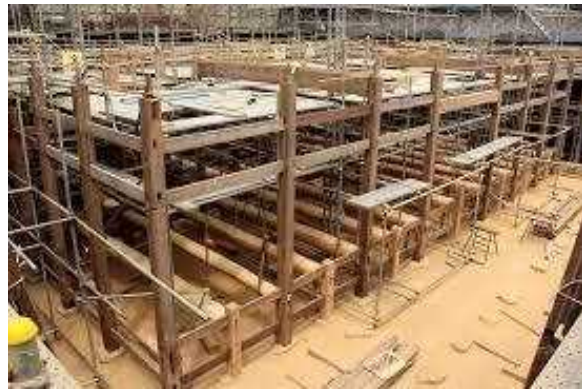
本堂修復工事状況
