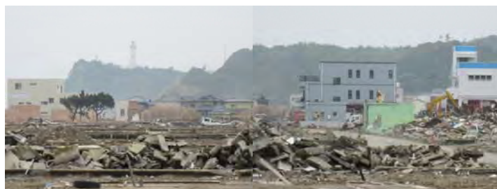
薄磯地区被災状況
