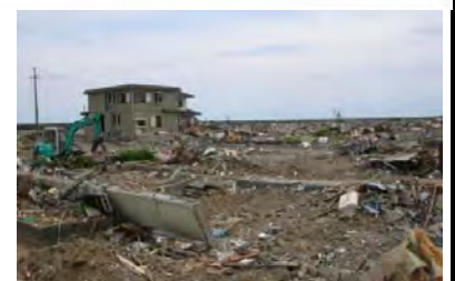
久之浜（海側）被災状況
