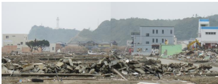
薄磯地区被災状況
