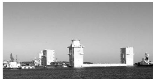
小名浜港で組み立て中の世界最大級浮体式風車
