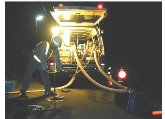
漏水防止(夜間流量調査)
