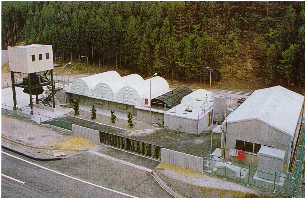
(写真: 浸出水処理施設)
