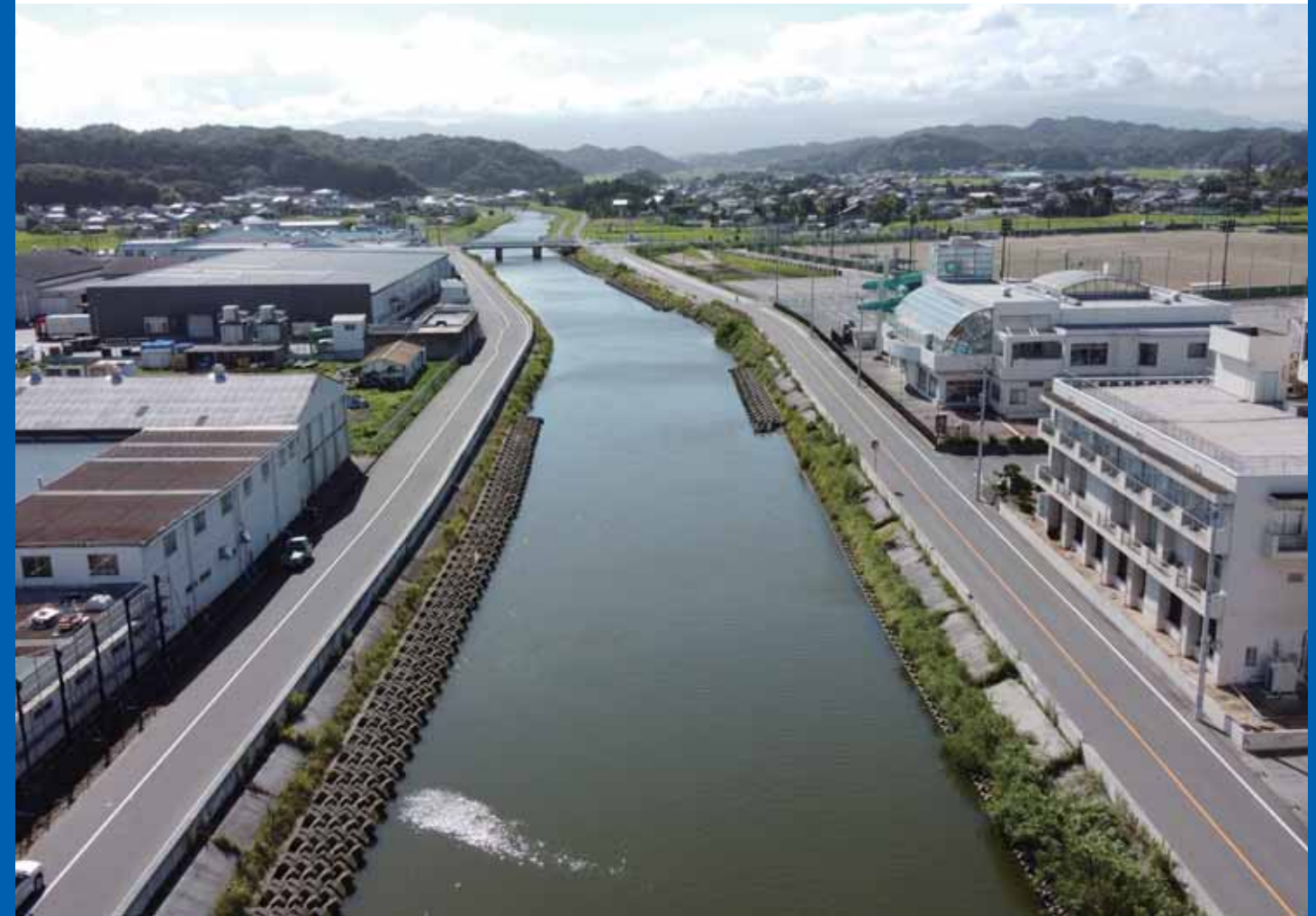
滑津川(河口付近) 令和3年8月3日 いわき市撮影
