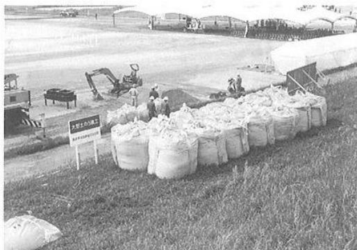
(大型土のう工)
