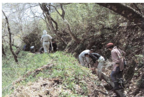
水路の泥上げ
