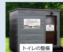
トイレの整備
