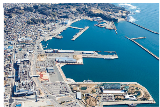
■写真2 小名浜港1, 2号ふ頭を西側から俯瞰 【平成31（2019）年3月 いわき市撮影】
