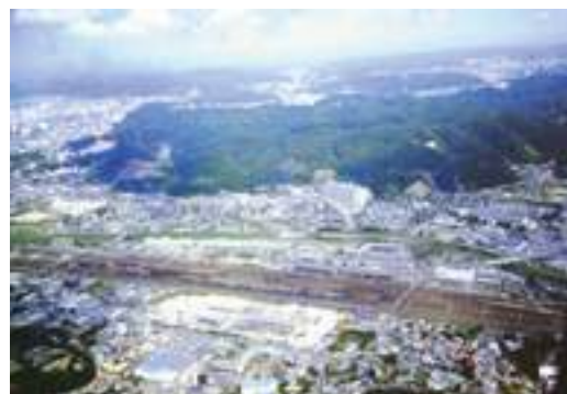
■写真3-9-35 後に市総合保健福祉センターが建つ「内郷操車場」 [平成元(1989)年6月 いわき市撮影]
