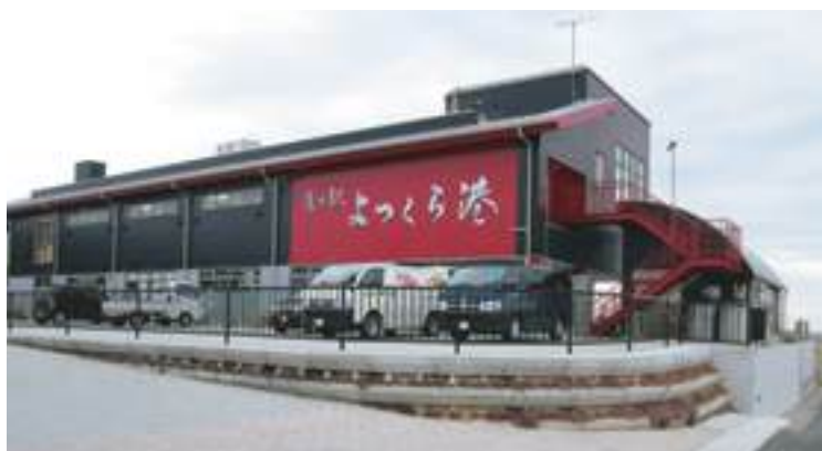
■写真3-11-81 リニューアルオープンした「道の駅よつくら港」交流館 [平成25(2013)年3月 いわき市撮影]
