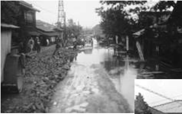
■写真5-内郷3-1 内郷綴町 国道6号の拡幅工事。平方向を見えています。〔昭和15(1940)年ごろ 磐城国道事務所所蔵〕
