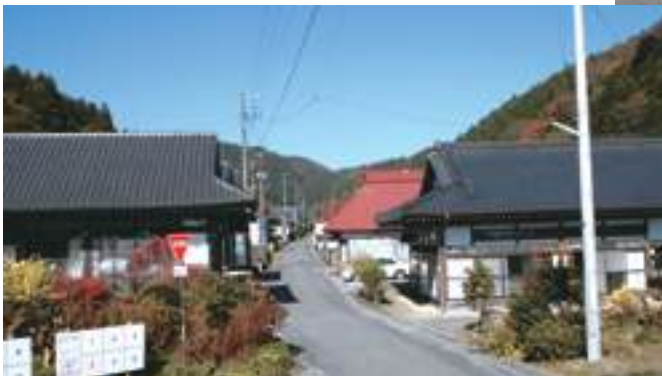
写真5-三和2-2 三和町上市萱字諏訪 茅葺き屋根は姿を消してトタン、 あるいは瓦葺きとなりました。〔平成26(2014)年10月 いわき市撮影〕
