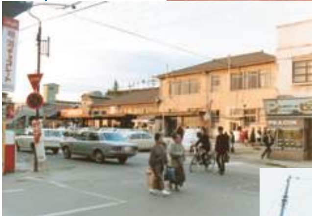
■写真5-平1-2 平(現いわき) 駅前 駅舎老朽化が進み、改築直前の写真です。〔昭和47(1972)年11月 いわき市撮影〕
