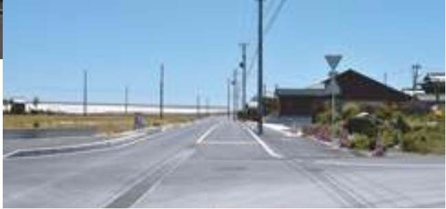
■写真5-久之浜・大久7-2 久之浜町久之浜字北町 東日本大震災で大きな被害を受け、火災も発生しました。街は壊滅状態から立ち上がり、復興途上です。〔平成27(2015)年7月 いわき市撮影〕
