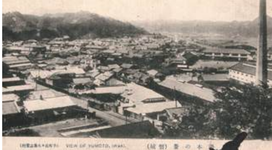
■写真5-常磐2-2 常磐湯本町天王崎、吹谷、三函（北方向）右側の煙突は品川白煉瓦の工場。周辺はすっかり市街化されています。〔大正時代 郵便絵はがき 佐々木商店発行〕
