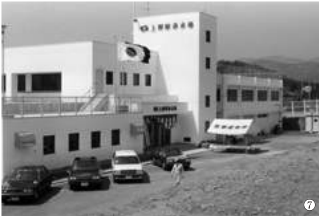
写真3-6-7 上野原浄水場 [昭和62(1987)年4月 いわき市撮影]
