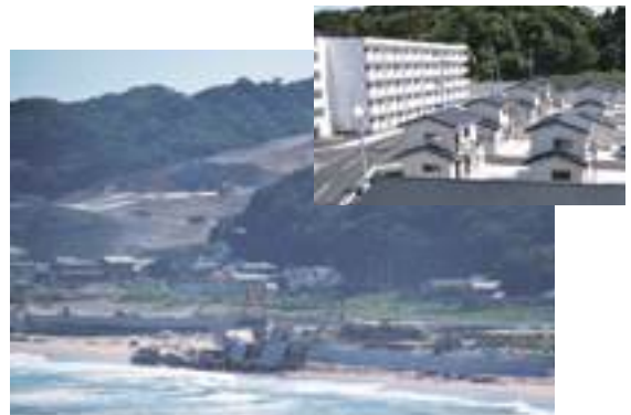
写真4-9 津波被災地区の区画整理事業では、高台移転工事も行っていきます。災害公営住宅は、被災した方々の暮らし方に合った様々なタイプを用意。〔平成27(2015)年7月 いわき市撮影〕
