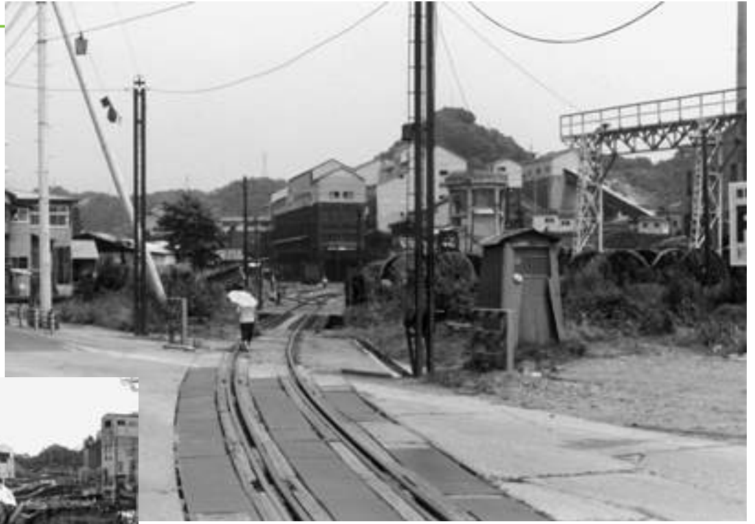
■写真5-常磐5-1 常磐湯本町向田 国道6号と交差していた常磐炭礦の専用鉄道向田線です。写真奥に常磐炭礦西部礦業所の石炭積込場などの施設が見えます。〔昭和51(1976)年7月 須永秀夫氏撮影〕
