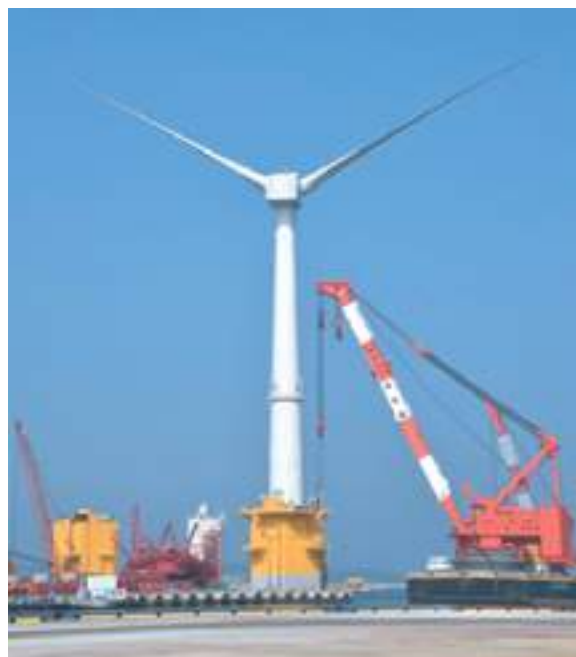
■写真3-11-140 浮体式洋上風力発電施設が小名浜港藤原ふ頭で組み立て [平成27(2015)年6月 いわき市撮影]
