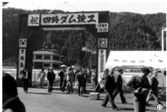
■写真3-5-12 四時川上流に多目的の「四時ダム」が竣工〔昭和58(1983)年10月 いわき市撮影〕
