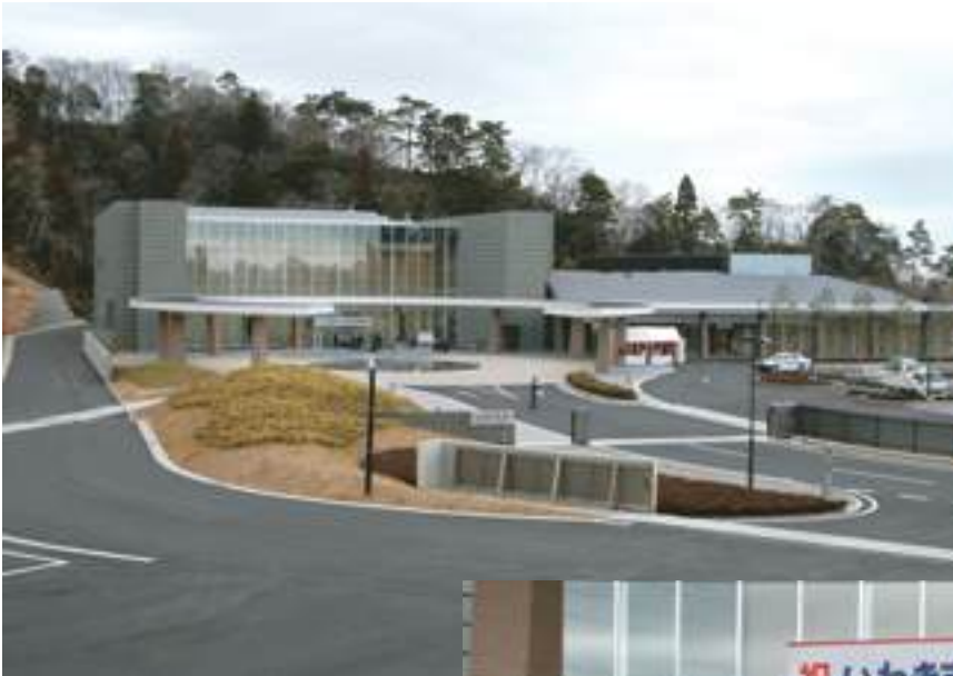
■写真3-10-41 「いわき清苑」の外観 [平成20(2008)年3月 いわき市撮影]
