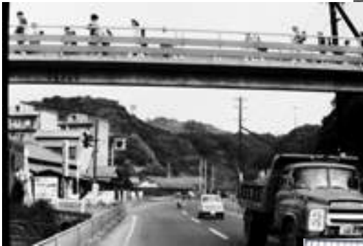
■写真5-常磐3-2 常磐湯本町傾城 写真左には学校や炭鉱住宅が、写真右には炭鉱住宅や常磐炭礦の施設群が、それぞれ控えており、行き来が多かったことから、昭和41(1966)年12月に市内で初めて横断歩道橋が建設されました。〔昭和43(1968)年10月 いわき市撮影〕
