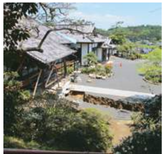
写真3-11-29 藤原断層の上で被災した常磐藤原町の建徳寺 [平成23(2011)年4月14日 菅波晋氏提供]
