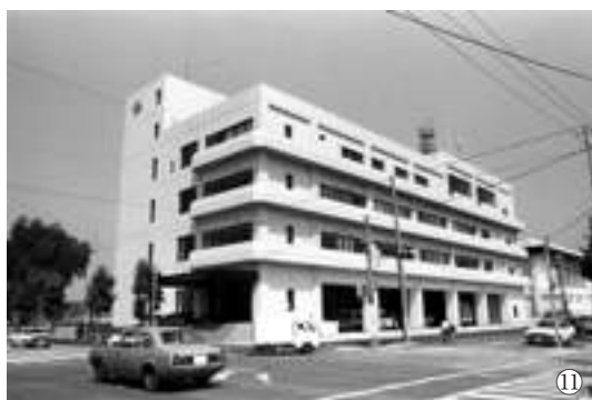
■写真3-5-11 消防本部と平消防署の統合庁舎が完成〔昭和58(1983)年8月 いわき市撮影〕
