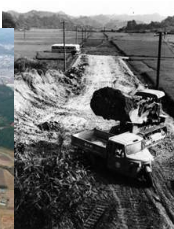
■写真5-小名浜9-1 鹿島町上矢田 真っすぐに伸びているのが、施工中の鹿島街道です。乗合バスは曲がりくねった鹿島街道を走っています。周りには見渡す限りの水田が広がっています。[昭和38(1963)年3月 比佐不二夫氏提供]
