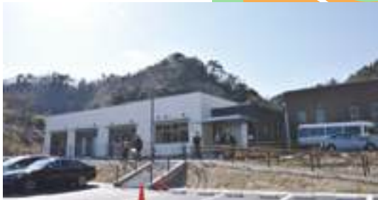
■写真3-11-94 新たに建設した江名市民サービスセンター・江名公民館 [平成27(2015)年4月 いわき市撮影]
