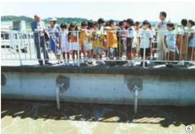
■写真3-6-6 市中部浄化センターが小名浜大原に完成(昭和61年10月) 下水道促進デーの見学。〔平成9(1997)年9月 いわき市撮影〕
