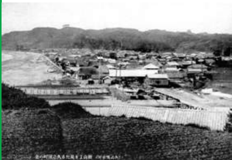
■写真2-13-1 大久川河口域に発達した久之浜市街を館山から遠望 〔昭和時代初期 郵便絵はがき 小泉屋文庫提供〕
