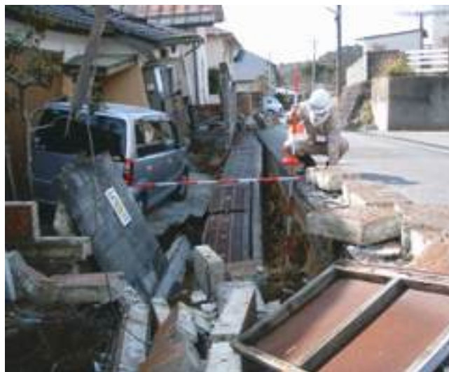
写真3-11-61 常磐西郷町忠多地内の被災状況 [平成23年(2011)年3月17日 いわき市撮影]
