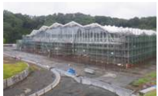
■写真3-11-158 災害時拠点施設の建設工事 (21世紀の森公園) [平成28(2016)年8月 いわき市撮影]
