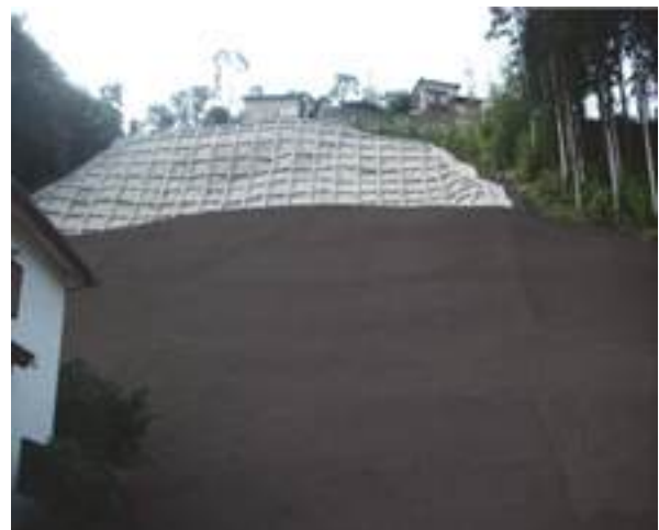
写真3-11-117 「県災害関連緊急急傾斜地崩壊対策事業」で施工した駒谷地内 〔平成24(2012)年12月 福島県いわき建設事務所提供〕
