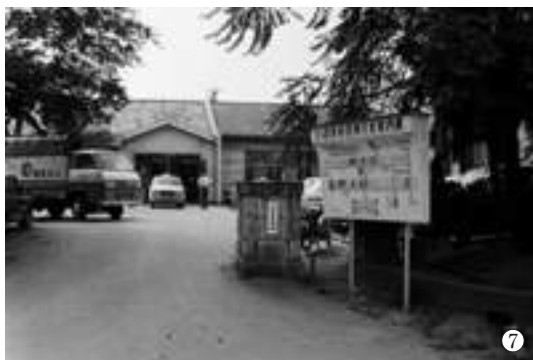
写真3-3-7 新庁舎が完成するまで、仮庁舎として利用された旧平商業高校の施設 [昭和44(1969)年9月 いわき市撮影]
