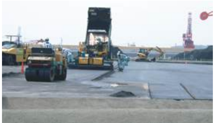
■写真3-11-51 復旧が進む小名浜港の5・6号ふ頭 [平成23(2011)年8月 いわき市撮影]
