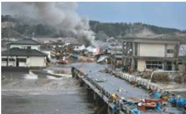
■ 写真3-11-73 津波来襲後、久之浜市街中央部で発生した火災 手前の橋は大久川に架かる陰磯橋。 [平成23(2011)年3月11日 石川弘子氏提供]
