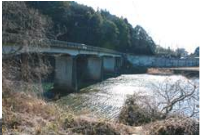
■写真5-田人1-2 井戸沢橋 橋は昭和29(1954)年にコンクリート化されましたが、平成17(2005)年に下流側に川原大橋ができて以降、通行は少なくなりました。【平成25(2013)年2月 いわき市撮影】
