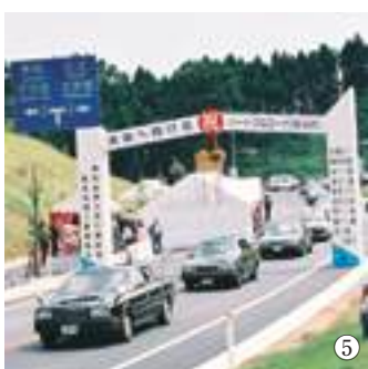
■写真3-7-5 国道49号平バイパスが全線開通 [平成7(1995)年9月 いわき市撮影]
