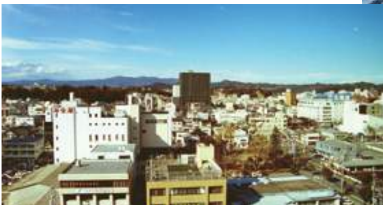
■写真3-9-28 ティーワンビル全景 市役所本庁舎から見た、ひときわ目立つ建物です。 [平成14(2002)年1月 いわき市撮影]
