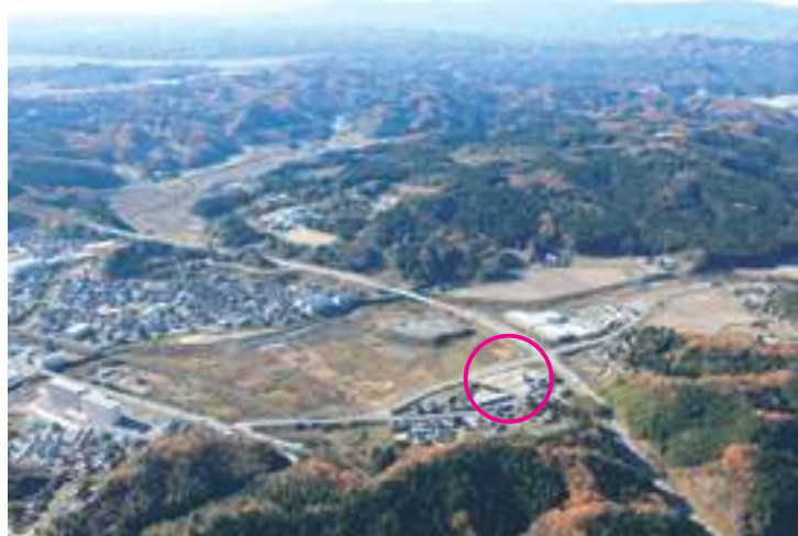
■ 写真3-11-72 金ヶ沢地区の防災集団移転先となった大久町大久(写真中央の国道6号久之浜バイパス東<海>側) [平成27(2015)年12月いわき市撮影]
