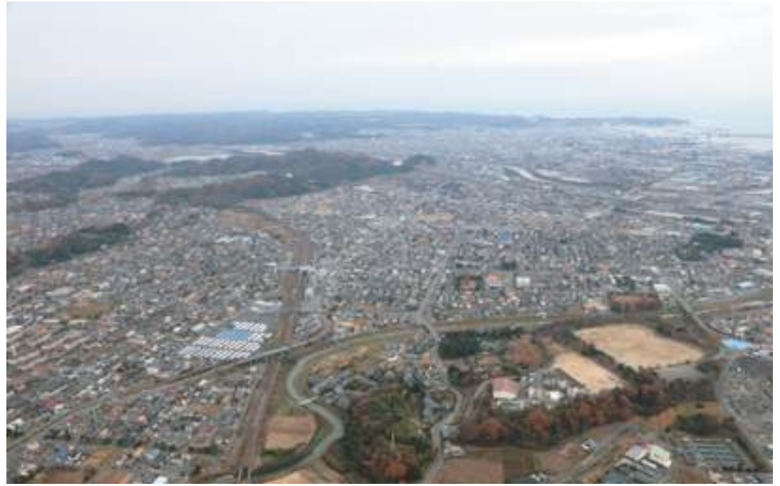
■写真5-小名浜7-2 泉町 泉町では土地区画整理事業が施工され、宅地化が進みました。昔の写真はこの写真の中央やや右寄りから撮ったものです。〔平成27(2015)年12月 いわき市撮影〕
