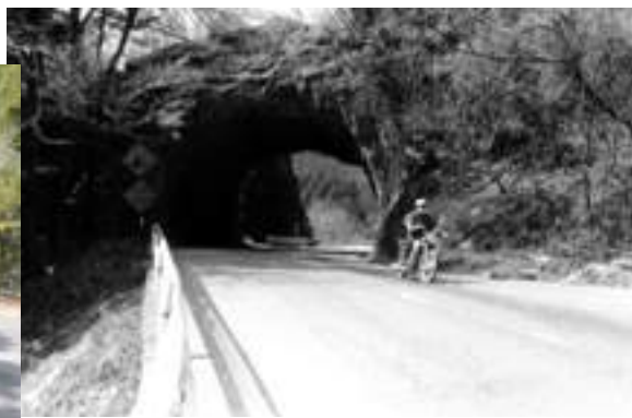
■写真5-遠野2-1 素掘りでくりぬいた御齋所洞門 鮫川峡谷の中腹を縫うようにして通じていました。【昭和52(1977)年3月 いわき市撮影】
