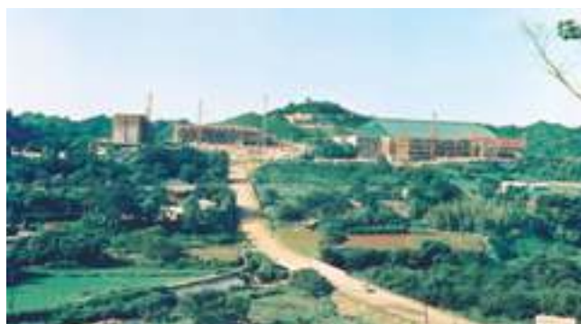
■写真2-4-8 建設中の常磐ハワイアンセンター(現スパリゾートハワイアンズ) [昭和40(1965)年8月 常磐市撮影]
