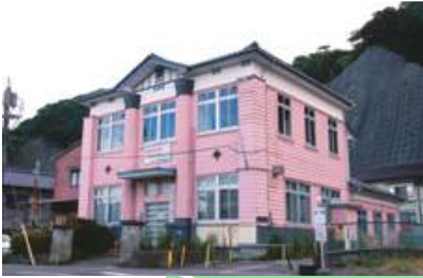
■写真3-11-93 耐震上の問題で閉鎖された江名市民サービスセンター [平成24(2012)年8月 いわきジャーナル撮影]
