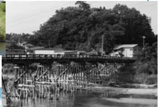
■写真5-平8-2 夏井川・鎌田橋 昭和11(1936)年に上流側に平神橋、昭和42(1967)年に下流側に平大橋が完成。橋の重要度は低下し、木橋は流失のたびに廃止が検討されました。〔昭和52(1977)年 いわき市撮影〕
