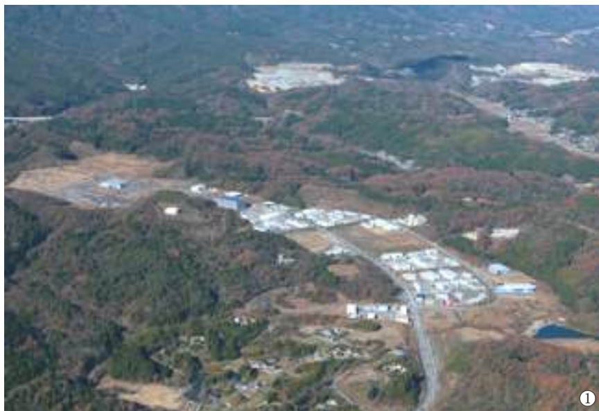
■写真3-10-1 空から見る「いわき四倉中核工業団地」(平成18年4月に分譲開始) [平成26(2014)年12月いわき市撮影]
