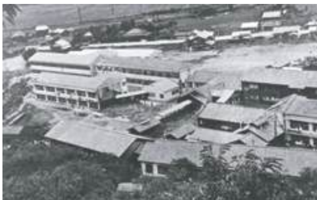
■写真2-5-6 磐城共立病院 1市29町村の組合病院として発足しました。東側の山上から俯瞰しています。〔昭和30(1955)年ごろ 『いわき市立総合磐城共立病院三十年史』から引用〕
