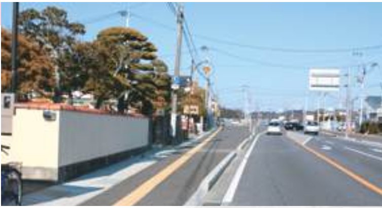
■写真5-勿来6-3 錦町大島 鮫川架橋から60年余、下流側に橋架け替えの際、既設道路の東側に取り付け道路も新設しました。写真左側に旧道の一部が見えます。〔平成25(2013)年2月 いわき市撮影〕
