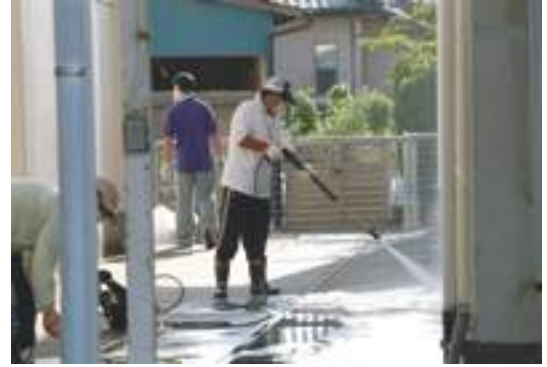
■写真3-11-138 高圧洗浄による除染作業(市立小名浜第三小学校) [平成23(2011)年8月 いわき市撮影]
