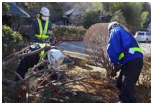
■写真3-11-137 住宅除染(平地区) [平成28(2016)年1月 いわき市撮影]
