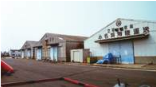
■写真3-8-80 整備前の倉庫群 [平成13(2001)年8月 いわき市撮影]
