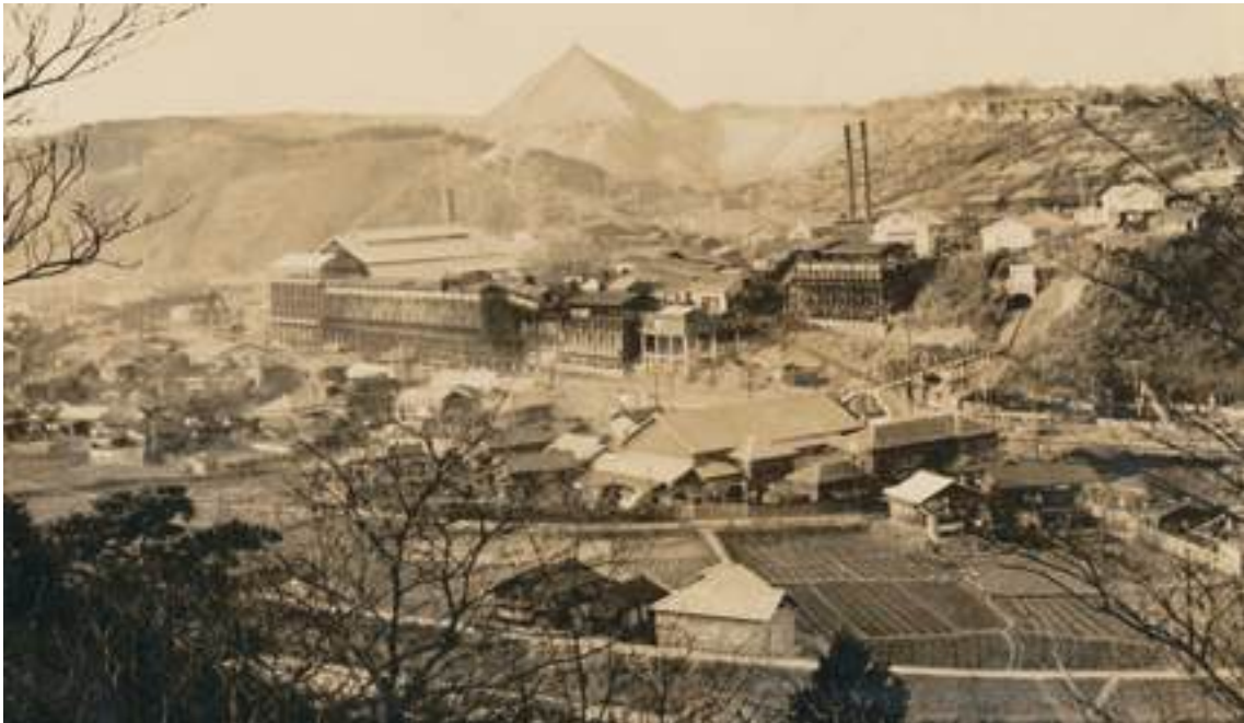
■写真2-5-3 内郷大字宮の磐城炭礦施設とずり山 ずり山とは、石炭を掘って選別した後の土砂を積み上げた山です。【昭和30(1955)年ごろ】
