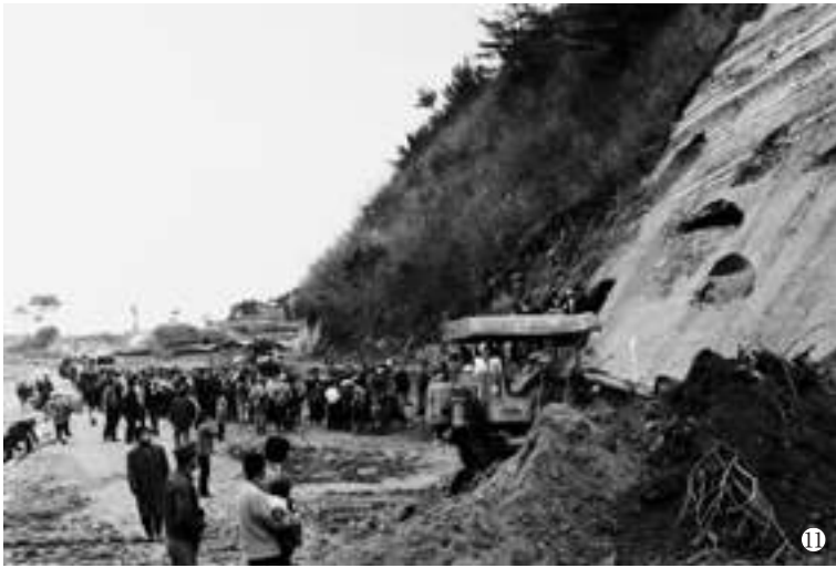
写真3-2-11 平沼ノ内地内の県道開削中に横穴（後に中田横穴と命名）が発見 [昭和44(1969)年1月 いわき市撮影]
