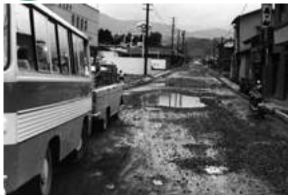
■写真5-遠野3-1 遠野町根岸 舗装前の道路は雨が降ると、水たまりができました。東方の遠野支所方向を見えています。【昭和42(1967)年7月 いわき市撮影】
