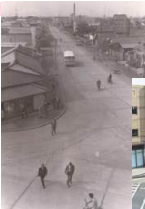
■写真5-小名浜3-1 小名浜花畑町 平と小名浜を結ぶ鹿島街道の整備は昭和30年代から始まりました。当時の磐城市役所（現小名浜支所）から通りを見えています。〔昭和30年代後半 比佐不二夫氏提供〕
