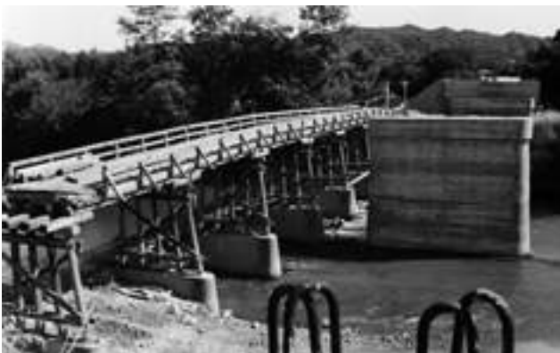
■写真5-小川3-2 広畑橋の架け替え工事 事故後、橋脚の補修などが施されましたが、その後全面的にコンクリート化が図られました。〔昭和48(1973)年10月 いわき市撮影〕
