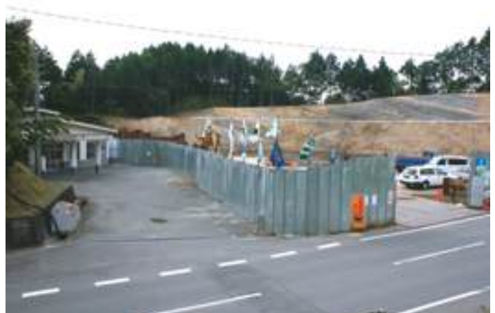
■写真3-10-44 整備が進む「市南部火葬場」 写真左に見えるのが現在の勿来火葬場。 [平成28(2016)年5月 いわき市撮影]
