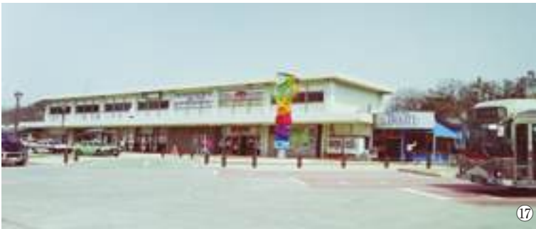
写真3-8-17 湯本駅前広場の整備が完成 [平成12(2000)年4月 いわき市撮影]
