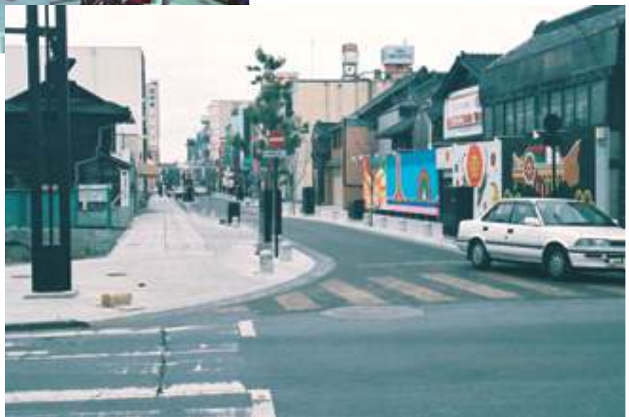
■写真3-9-25 再開発ビルの建設予定地〔平成7(1995)年 1月 いわき市撮影〕
