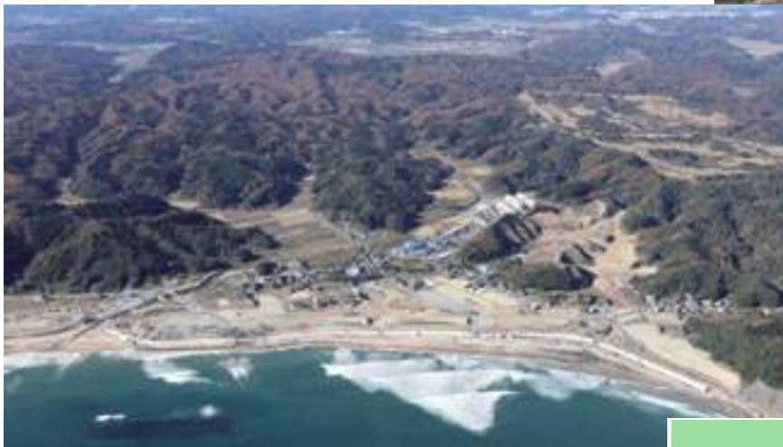
写真3-11-89 震災復興土地区画整理事業区域は平地と高台へ、さらに平地の一部には津波防災緑地などを配置され造成、海岸部では防潮堤のかさ上げ [平成27(2015)年12月 いわき市撮影]
