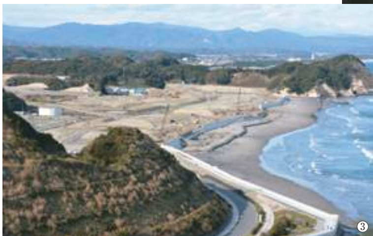
写真3-11-3 塩屋埼灯台から見る、薄磯地区における震災復興の状況 [平成27(2015)年11月 いわき市撮影]
