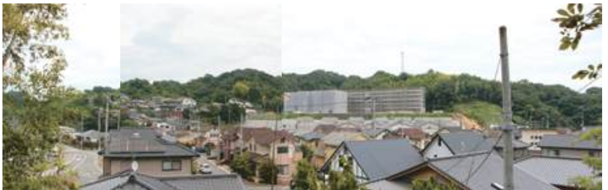
■写真5-常磐4-2 常磐湯本町下浅貝 炭鉱住宅の長屋やアパートは一般住宅へ、職員住宅は取り壊され、現在は災害公営住宅「市営下浅貝団地」となっています。〔平成27(2015)年7月 いわき市撮影〕
