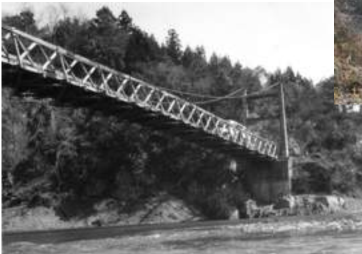
■写真5-田人1-1 井戸沢橋 昭和2(1927)年に架橋された吊り橋の上を乗合バスが通ります。【昭和20年代末 板津弥吉氏提供】
