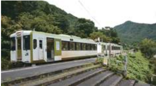
■写真5-小川5-2 江田駅 JR移行に伴い、駅に昇格しましたが、移動手段は鉄道からマイカーに移行して、めったに乗り降りが見られません。〔平成27(2015)年9月 いわき市撮影〕
