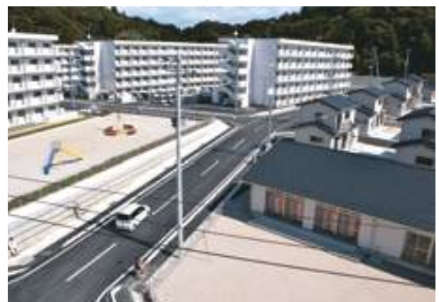
■写真3-11-114 災害公営住宅「市営永崎団地」および江名字走出の防災集団移転地〔平成27(2015)年10月 いわき市撮影〕
