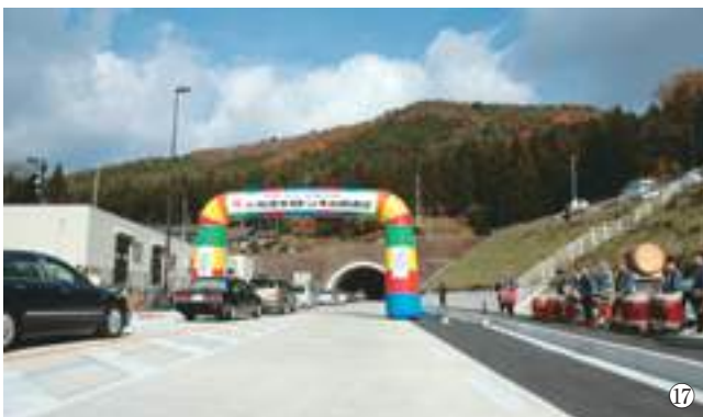
写真3-9-17 国道49号いわき水石トンネルが開通 [平成17(2005)年11月 いわき市撮影]
