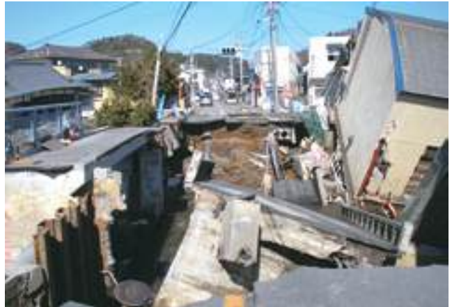
■写真3-11-95 大平川を溯上した津波は大平川一号橋を破壊 〔平成23(2011)年3月12日 いわき市撮影〕
