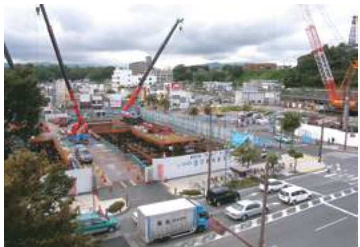
写真3-10-18 建設中の再開発ビルおよび駅ビル [平成18(2006)年10月 いわきジャーナル撮影]
