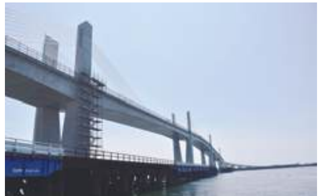
写真3-11-19 整備中の臨港道路(橋りょう)を3号埠頭から見る [平成28(2016)年8月 いわき市撮影]
