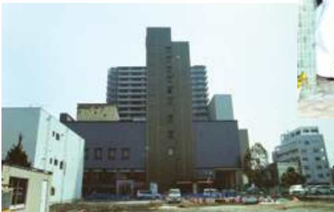
■写真3-9-27 ティーワンビル建設中 写真手前は、中心市街地活性化広場公園の「一町目公園」。 [平成14(2002)年1月 いわき市撮影]
