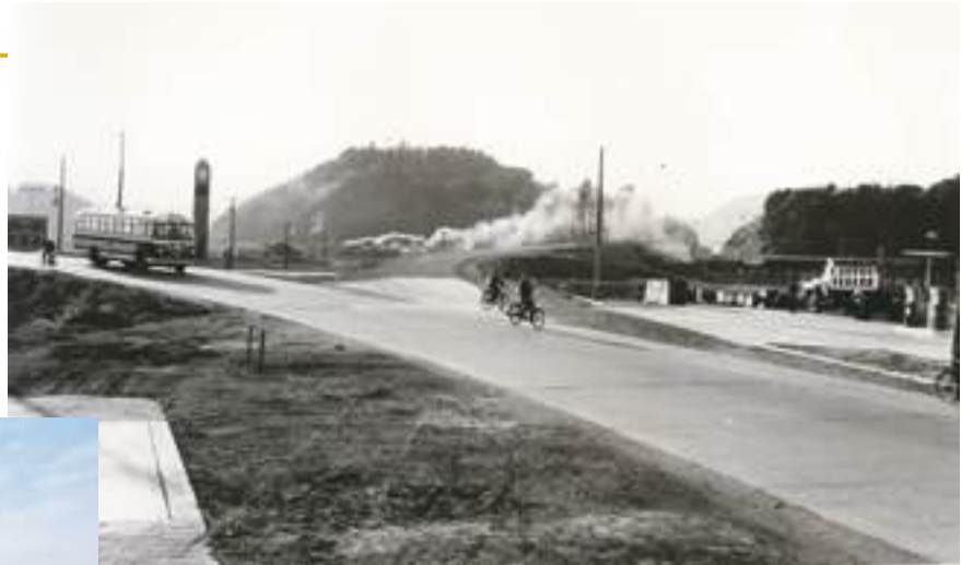
■写真5-内郷10-1 内郷御台境交差点 新川に架かる尼子橋近くに、新たに国道49号が建設され、交差点となりました。煙の尾を引いて蒸気機関車が通っていくのが見えます。〔昭和30年代初め 長谷川達雄氏撮影〕
