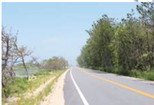
写真3-11-83 復旧が成った県道豊間-四倉線 [平成24(2012)年6月 いわき市撮影]
