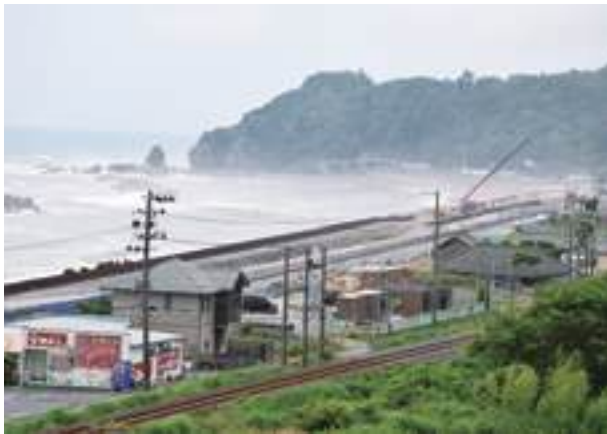
■写真5-久之浜・大久2-2 波立・弁天島 海岸沿いに国道6号が通じて、海岸は大きく変わりました。田之網字横川では、東日本大震災後の復旧・復興が進んでいます。〔平成28(2016)年6月 いわき市撮影〕
