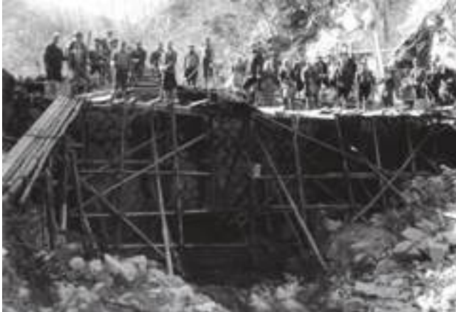
■写真2-14-5 大久川の河川砂防堤工事（大久村大字大久字番屋地内）【昭和17(1942)年 根本重光氏提供】
