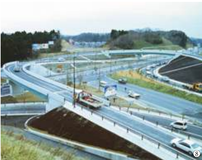
写真3-9-8 国道6号常磐バイパスと国道49号平バイパスの上矢田交差点が立体開通（常磐上矢田町）〔平成14(2002)年12月 いわき市撮影〕
