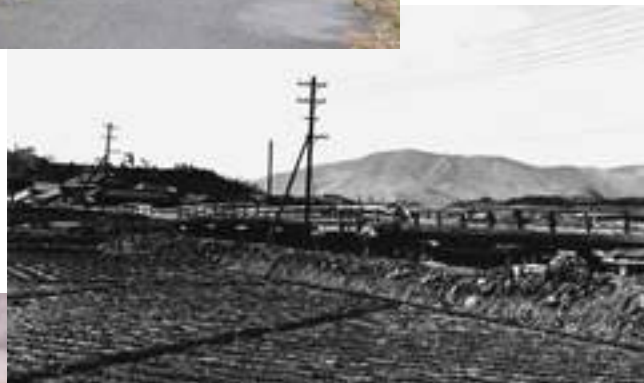
■写真5-内郷11-2 新川・尼子橋 国道でもあったことから往来が激しく、写真で見る橋はだいぶ老朽化しています。〔昭和28(1953)年2月 松本正平氏撮影・松本正夫氏提供〕
